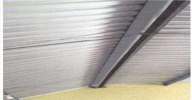
Mantenimiento a estructura
